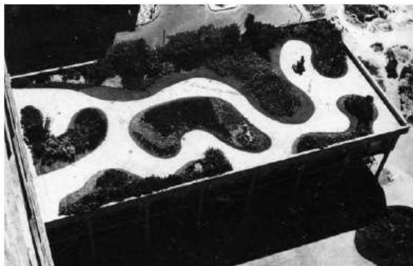
Figura 77: Terraço-jardim do Ministério da Educação e Saúde Pública, edifício Gustavo Capanema, 1938, Rio de Janeiro.
