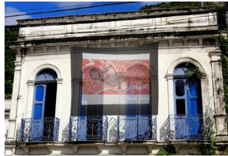
Figura 26 – projeto de instalação de gravura em macro escala na Casa Porto localizado no centro da cidade de Vitória/ES.
