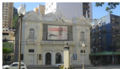
Figura 24 – projeto de instalação de gravura em macro escala no Teatro Carlos Gomes localizado no centro da cidade de Vitória/ES.
