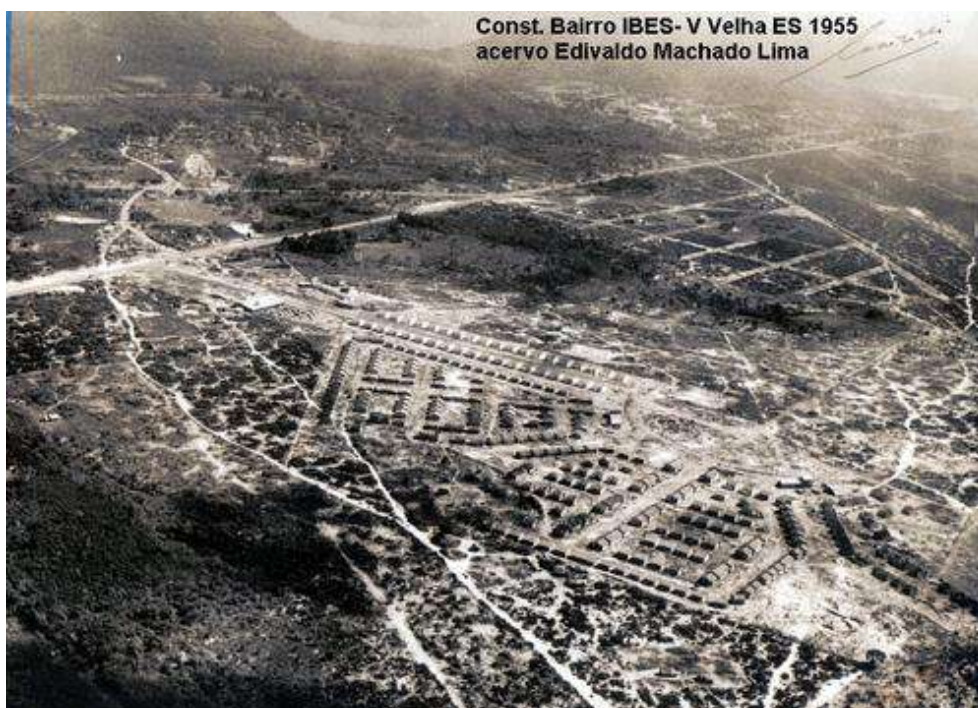
Fig. 59: Construção do Bairro IBES (VIAJE AQUI, 2011, p.01)
