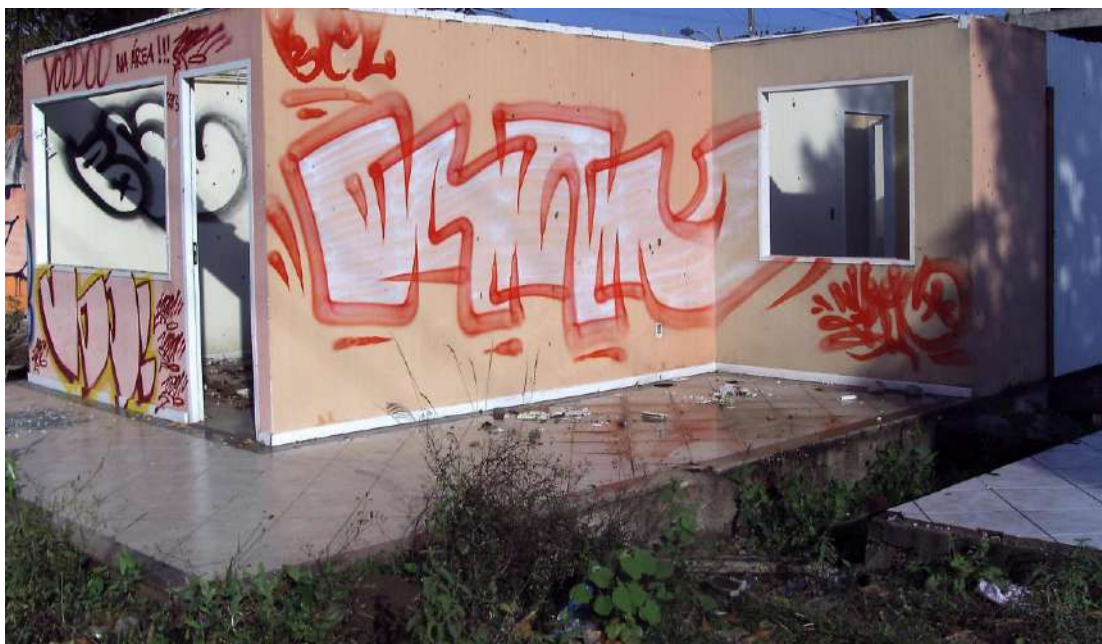
Fig. 94: Ação de grafiteiros em demolição (MICHALOVZKEY, 2013)
