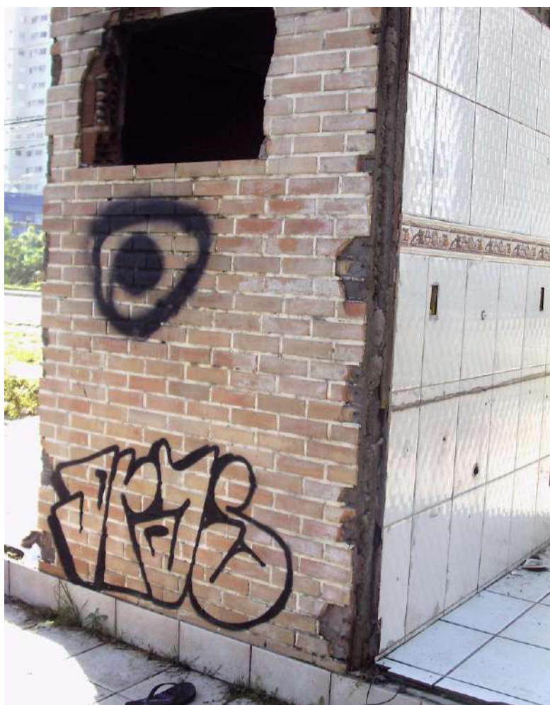
Fig. 95: Ação de grafiteiros em demolição (MICHALOVZKEY, 2013)
