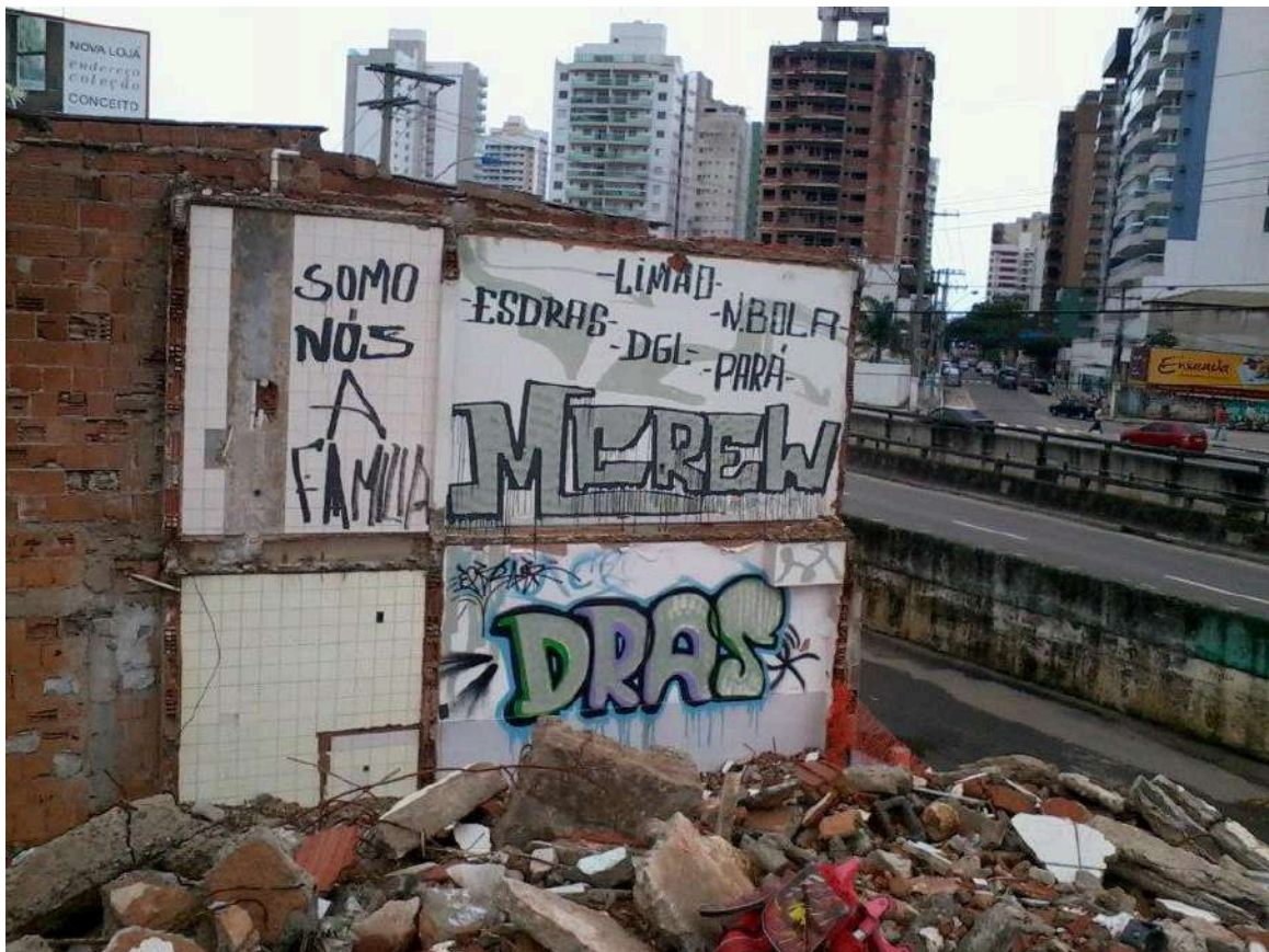
Figura 59: Tag M.crew em construção em estado de demolição em Vila Velha ao lado da terceira ponte.
